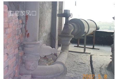
由于生产过程中风的需求量取决于燃料质量，原材料质量。另外，整个生产过程中不同的时间段对风的需求量也有很大不同。因此，在整个生产过程中，送入窑炉的通风量需要经常调整。在传统的送风系统中，风机时刻处于额定转速运转，即送风量是固定的。风量的调整是靠放风阀的开度进行的。或者说，每当窑炉对风的需求量减少时，便是能量浪费产生的时刻。窑炉需要的风量越小，能量浪费越严重。据在某一生产现场统计，窑炉极少需要满风量，一半时间处于80% 的满风量，另一半时间风量的需求约为65% 的满风量。这种情况下，不需要的那20% 和35% 的风量就白白浪费掉了。前者的能量浪费约为48%，而后的能量浪费竟达到65%！
